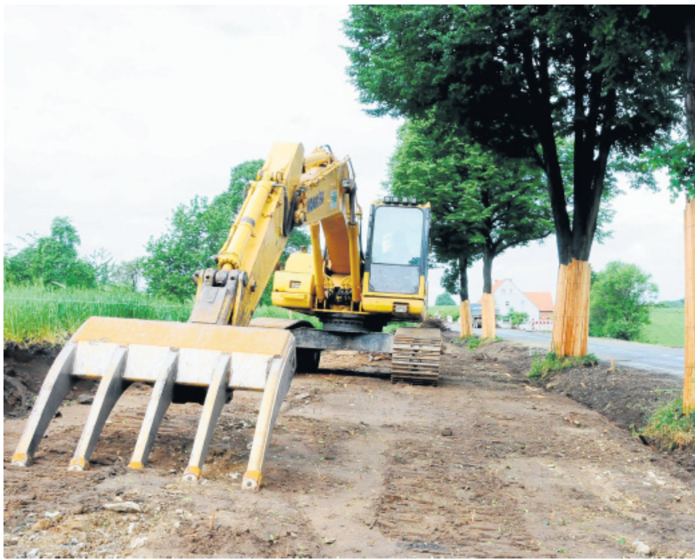
Das Baufeld ist geräumt: Da, wo der Bagger mit seiner gewaltigen Schaufel steht, wird künftig der Radweg an der Verbindungsstraße zwischen Halle und Werther entlangführen. Rechts befindet sich der Grüne Weg mit Blick in Richtung Lindenstadt. FOTO: R. UHLEMEIER
